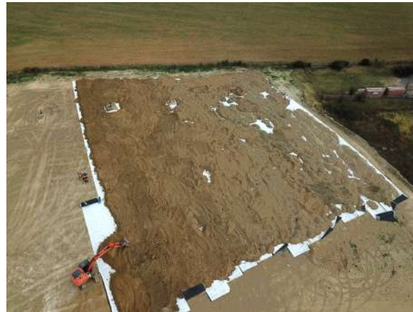
DEGD = dispositif d'étanchéité par géomembrane de drainage
