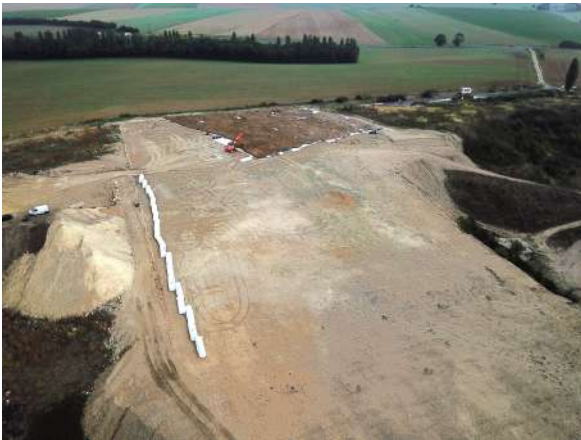
DEGD = dispositif d'étanchéité par géomembrane de drainage
